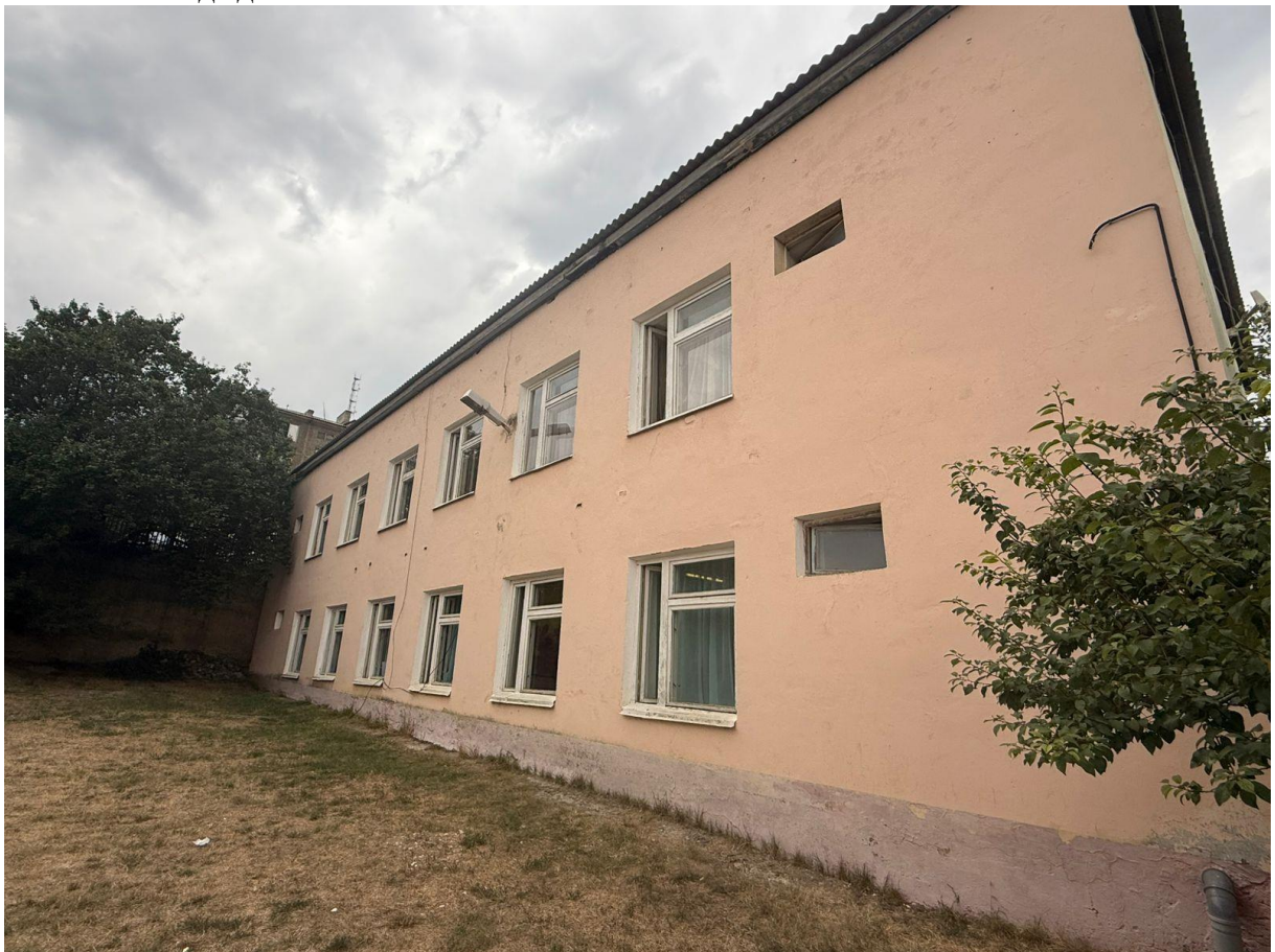
Фото 4. Фасад здания, Блок №1
