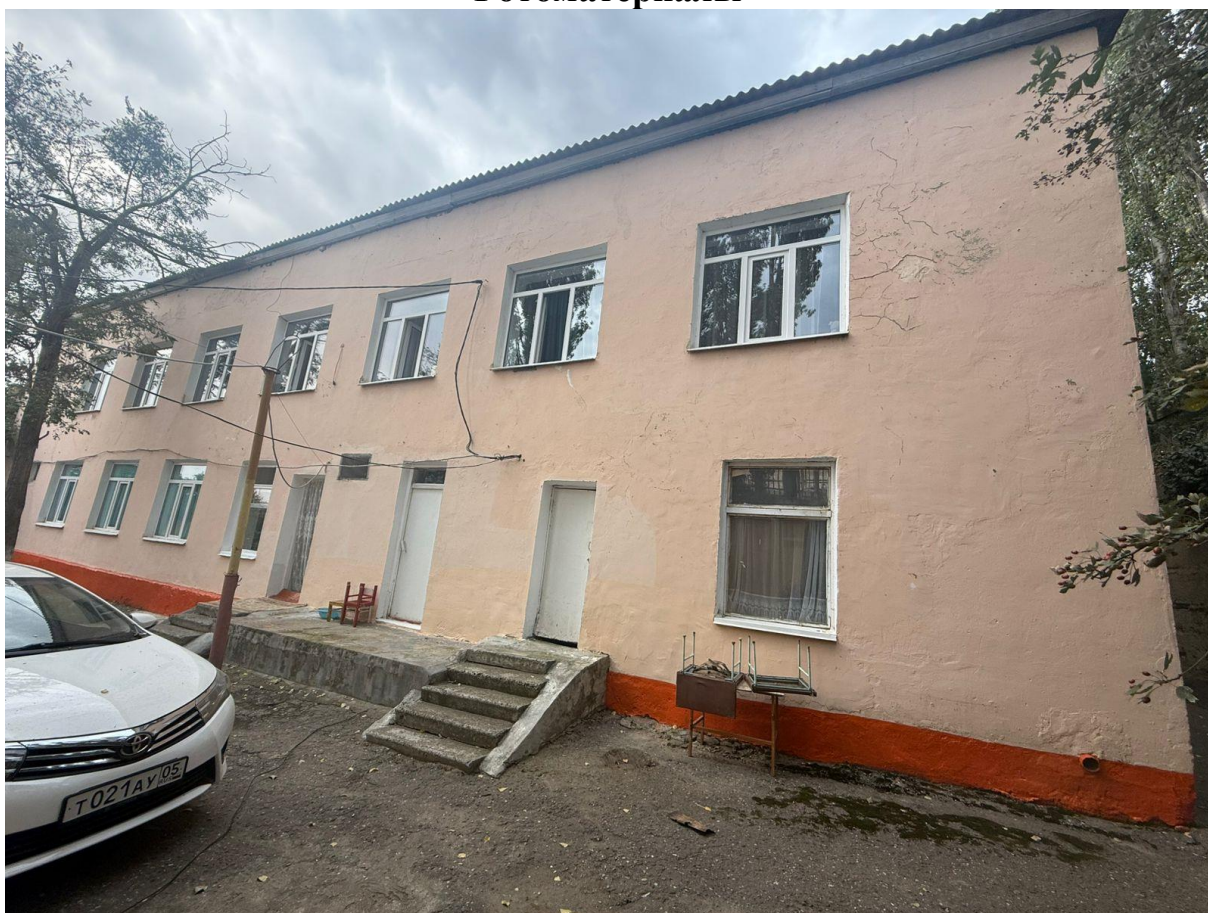
Фото 1. Фасад здания Блок №3
